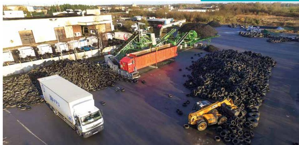
La nouvelle plate-forme SEVIA de Vern-sur-Seiche dispose de deux broyeurs et fonctionne en rétention totale des eaux de ruissellement. 3 000 tonnes y ont été valorisées en 2016, en phase de démarrage de l'installation. La majorité des pneus a été collectée et traitée pour le compte de France Recyclage Pneumatiques.
