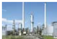
Contrôle des matériaux et inspection
