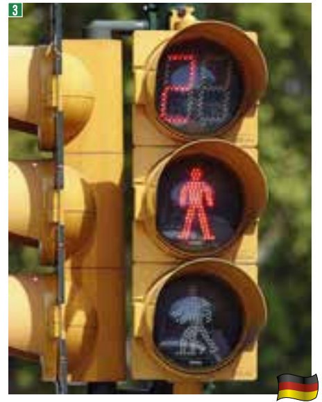
3 Feu pour piétons avec affichage élargi indiquant le temps restant du feu rouge
