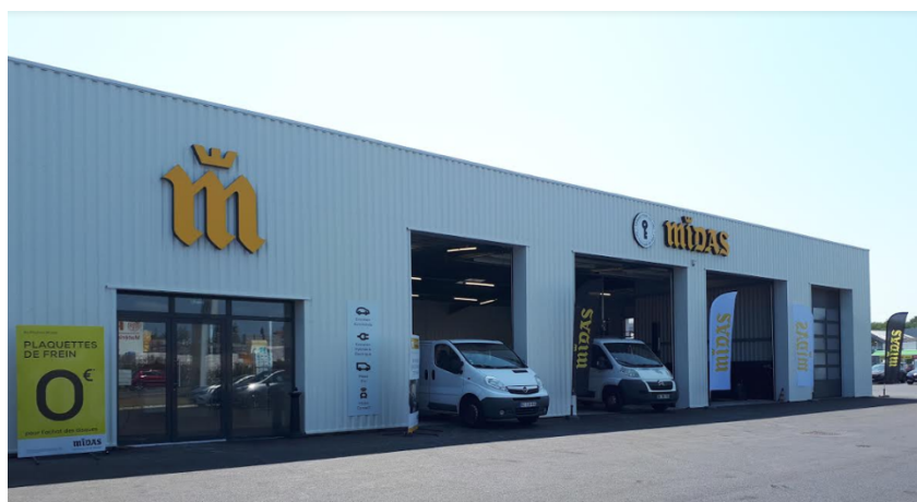
Le centre Midas de Saint-Paul-lès-Dax (40)
