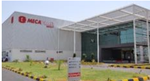
Usine de Chennai (Inde)
