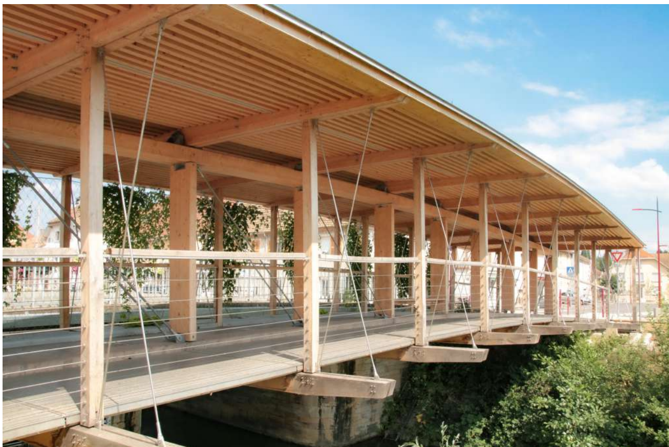
Passerelle Mirador, L'Isle-sur-le-Doubs ©Goetschy+Cabello
