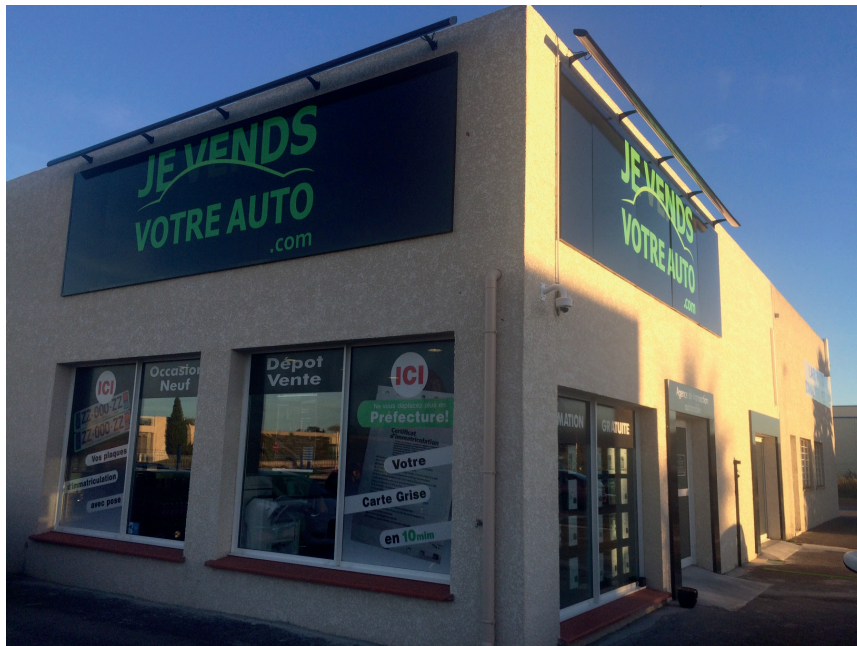
Site pilote de Saint-Laurent de la Salanque (66)
