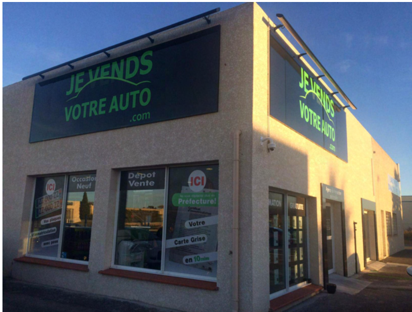
Site pilote de Saint-Laurent de la Salanque (66)
