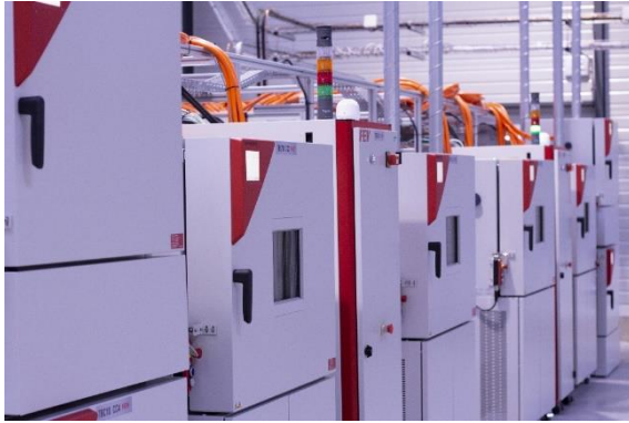
Bancs d'essais cellules du centre d'essais de Saint Quentin-En-Yvelines
