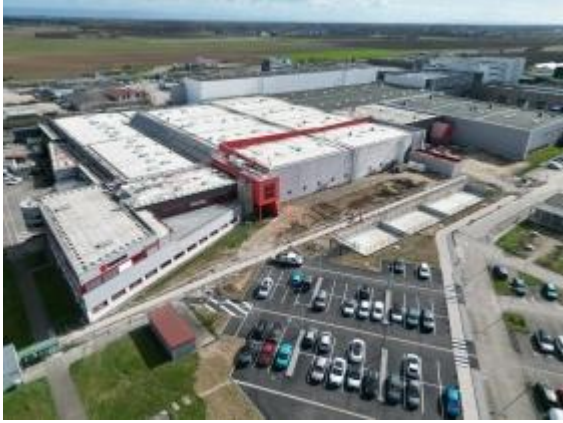
Vue drone plateforme logistique Würth à Erstein
