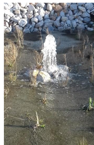
Les eaux de lavage percolent à travers une succession de couches afin d'être filtrées
