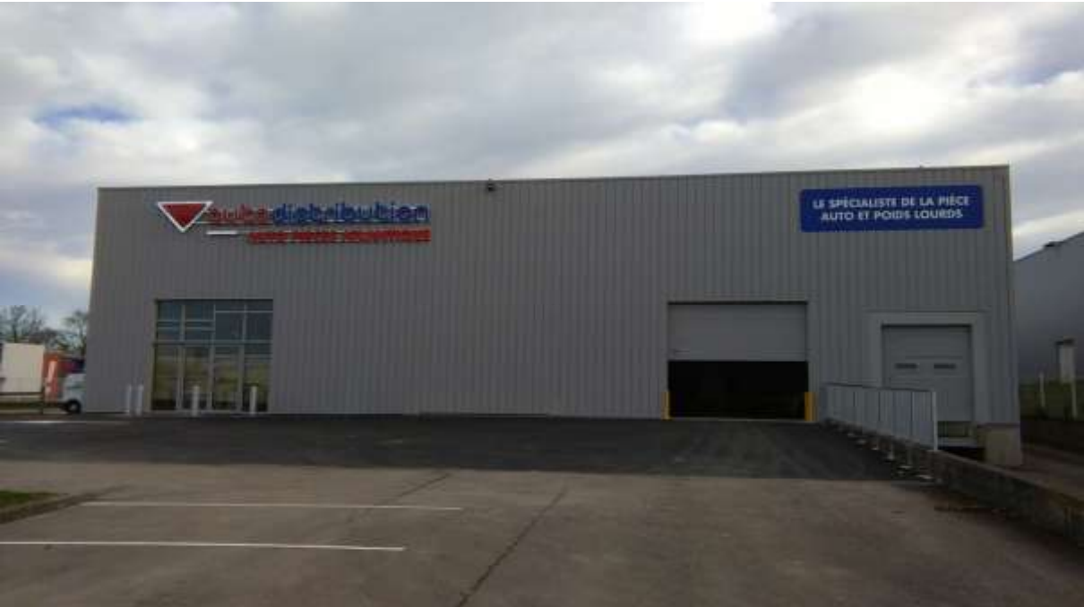
Photos nouveau magasin de Redon (travaux en cours)
