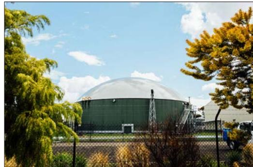
*Au début des travaux de maintenance, les cuves sont d'abord entièrement vidées. De plus, les toits des deux digesteurs en acier inoxydable d'une capacité de 3.573 mètres-cubes ainsi que des éléments internes de l'installation comme la technique d'agitation sont rénovés.*
