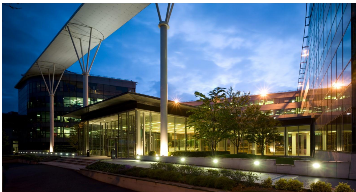
Bâtiment River Plaza, Asnières-sur-Seine
