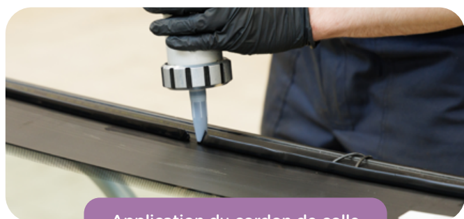
Application du cordon de colle
