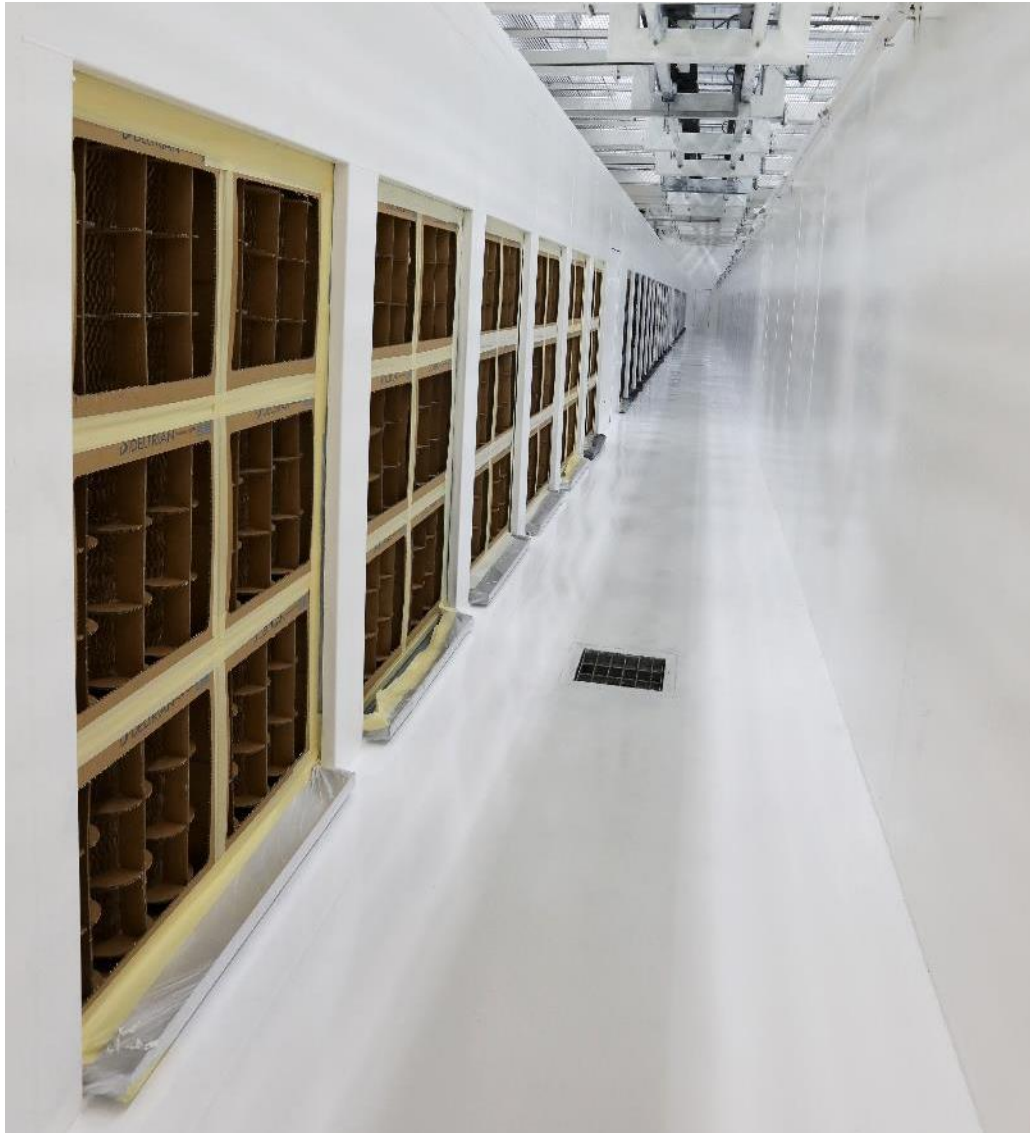
2° photo : EcoDry X se base sur des filtres en carton jetables et facilement remplaçables permettant de changer rapidement de filtre, même en cours de production.
